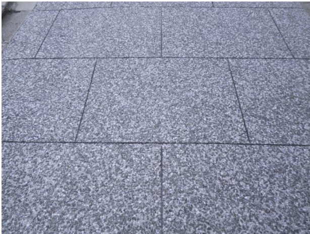
舗装表面 アスファルト舗装+ショットブラスト+目地切り
