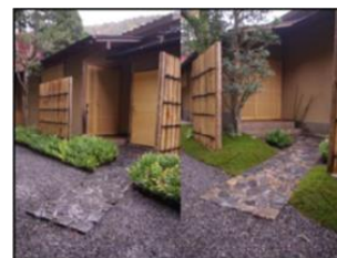
星のや京都での延段の施工
