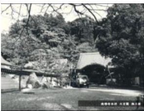
大玄関施工前
